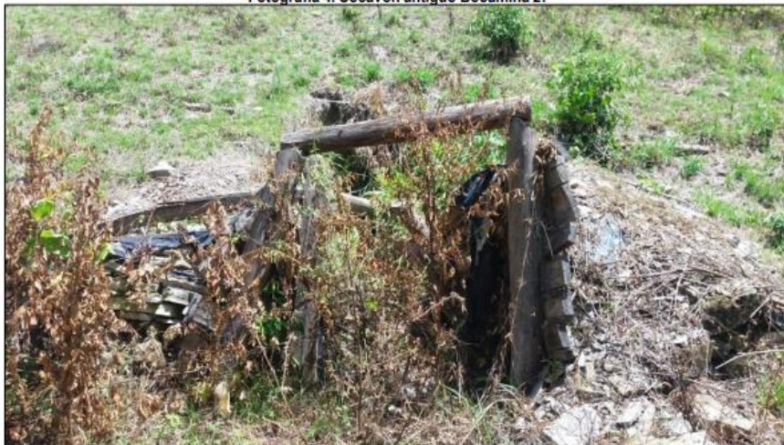
Fotografía 4. Socavón antiguo Bocamina 2.
