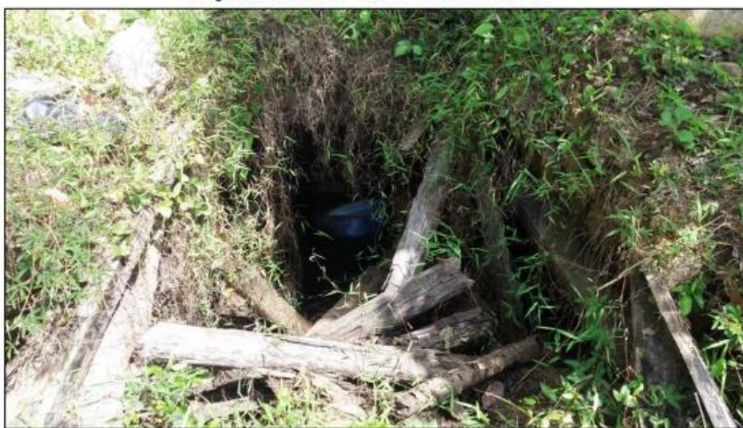
Fotografía 3. Bocamina 1 – Nótese Nivel de inundación
